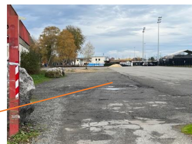
Accès au parking
